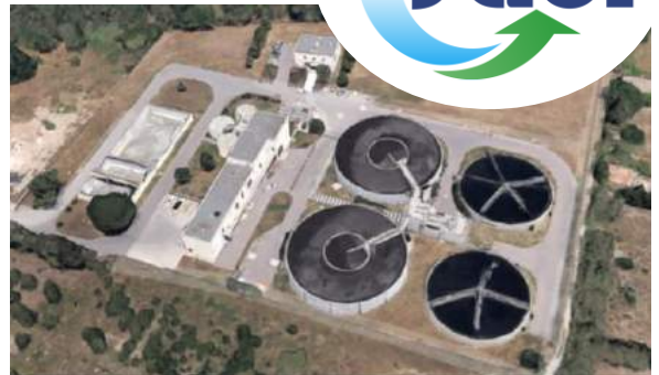
WWTP Le Canet en Roussillon
